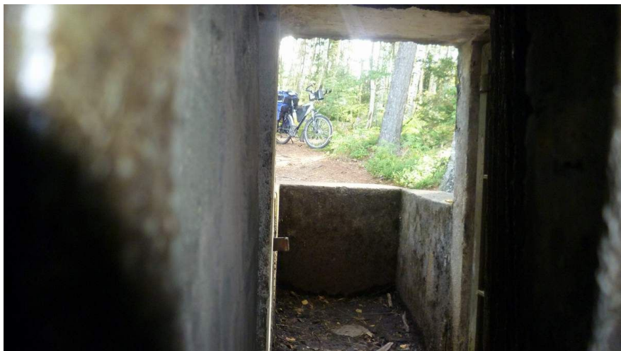
Pohled z bunkru
