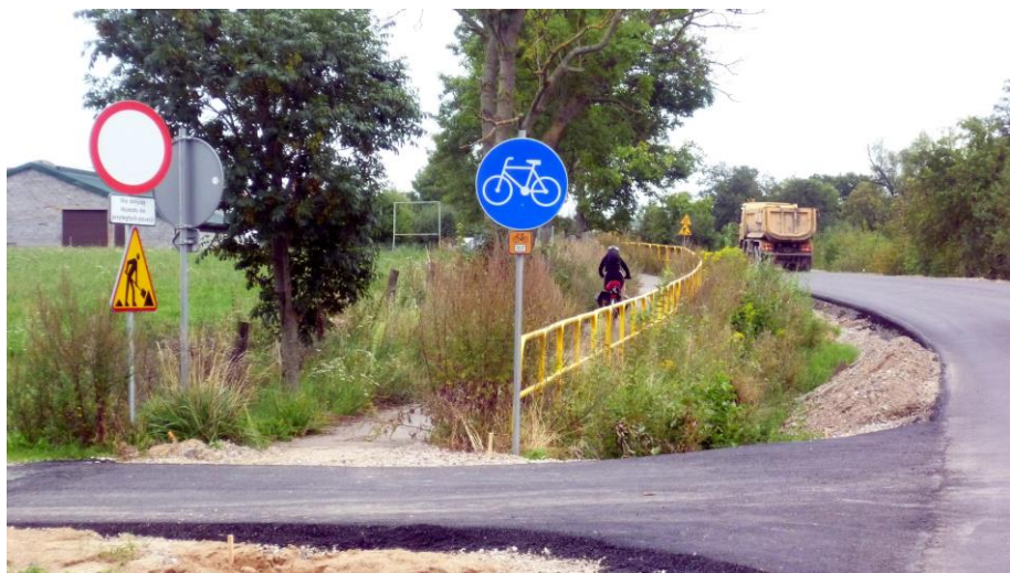
Hotová část nové silnice.
