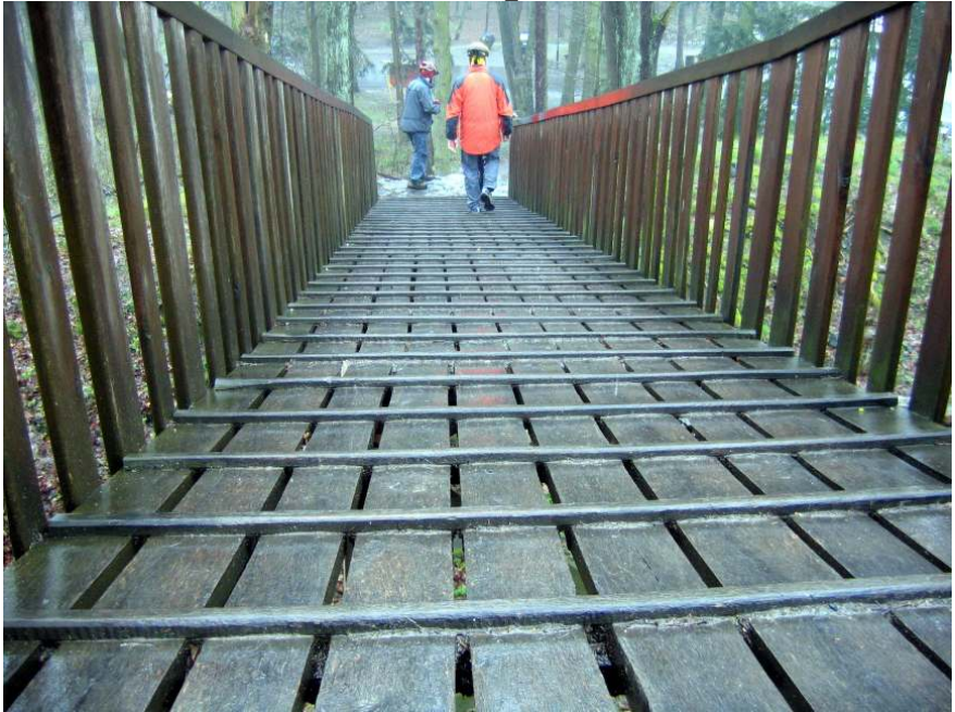
Radaně – přemostění příkopu
