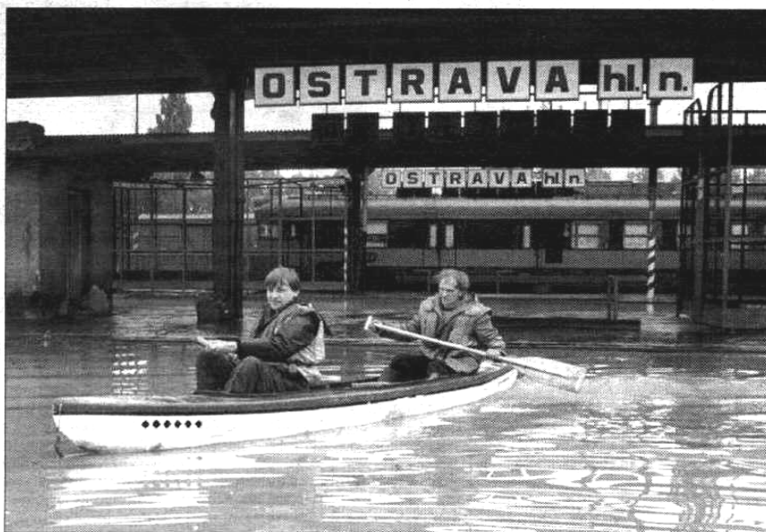
Železničáři proplouvají zatopenými nástupišti na hlavním nádraží v Ostravě
