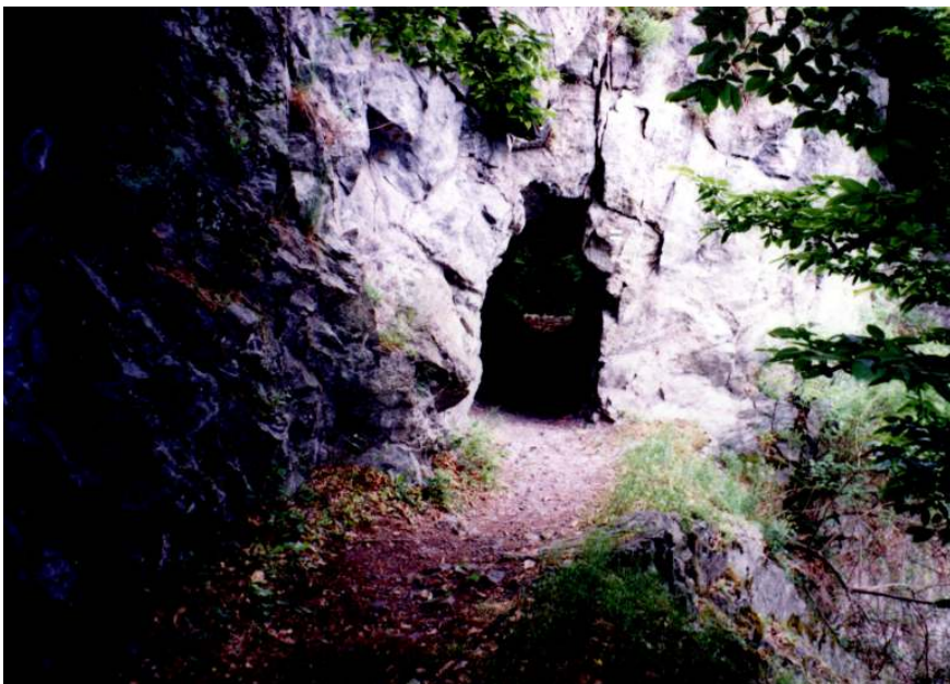
Pohled na ústí tunelu.
